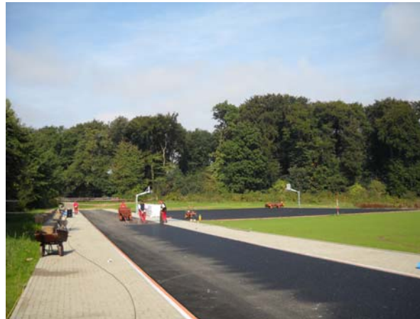
Asphaltierung vor der Aufbringung von Tartan
