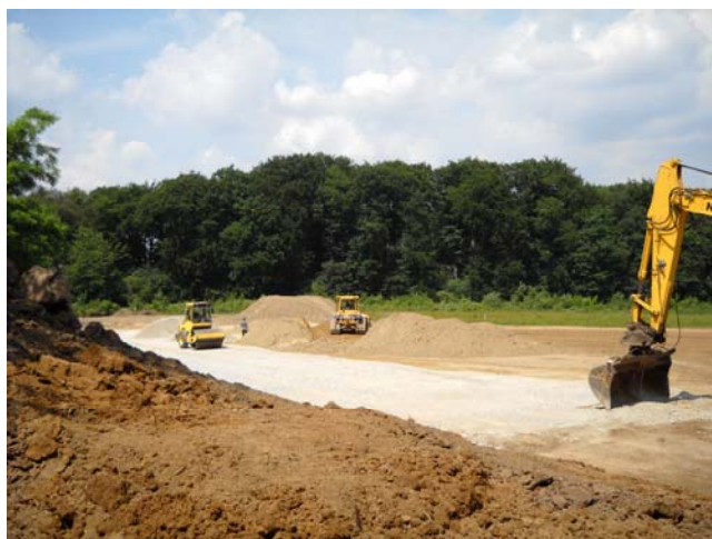
2 Wochen nach Baubeginn: „4000 to Erde werden bewegt“
